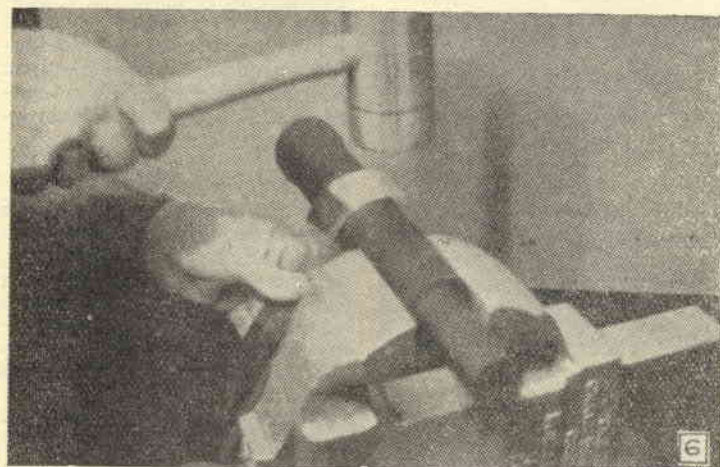
Foto 6 - Come viene iniziata la curvatura di una striscia di piattina di ferro. Come forma può essere usato un pezzo di verga o di tubo. Notate l'estremità un poco sporgente.
