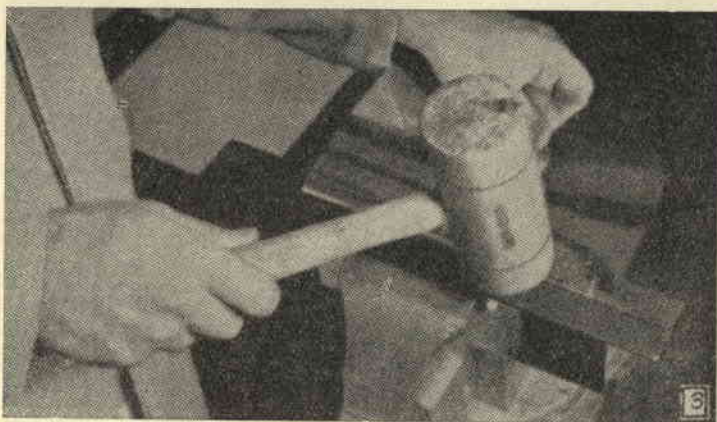
Foto 3 — Una volta eseguita a mano la piegatura, si effettua la squadratura agendo sulla superficie della lamiera con il mazzuolo di legno. Non usare un martello, che lascerebbe sul metallo un segno, che non sarebbe facile togliere.
