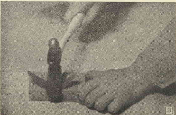
Foto 6 - Come viene iniziata la curvatura di una striscia di piattina di ferro. Come forma può essere usato un pezzo di verga o di tubo. Notate l'estremità un poco sporgente.
